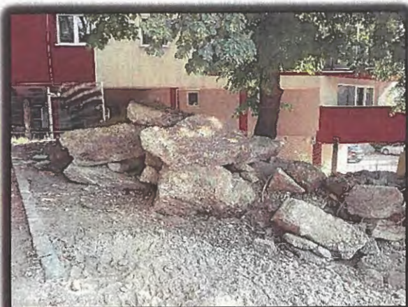
Výkop železobetónových blokov pri výkope základových pásov
