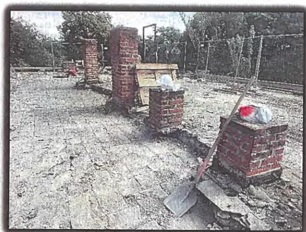
Vybúranie komínov na hlavnej streche
