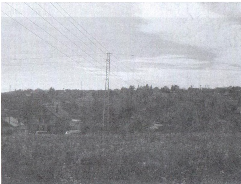
Križovanie s VN vedením 22kV a Podporný bod č. 69
