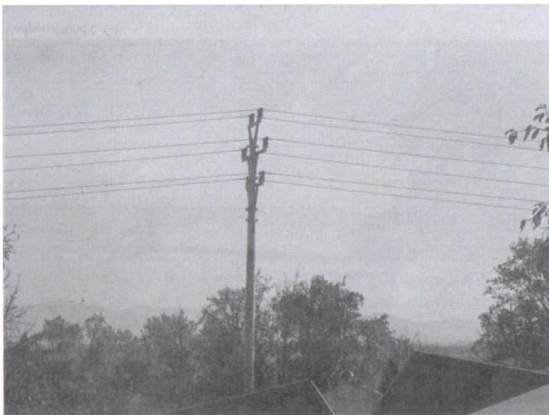
Podporný bod č. 63a
